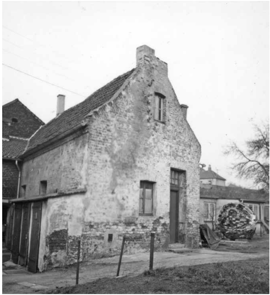
Die ehemalige Einsegnungskapelle wird zur Werkstatt. Fotos: unbekannt
